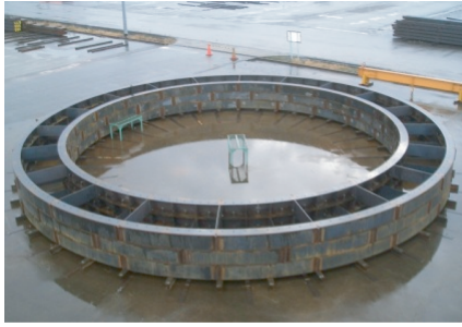
写真2 アーバンウォール®工法 Photo 2 Urban Wall™ method
